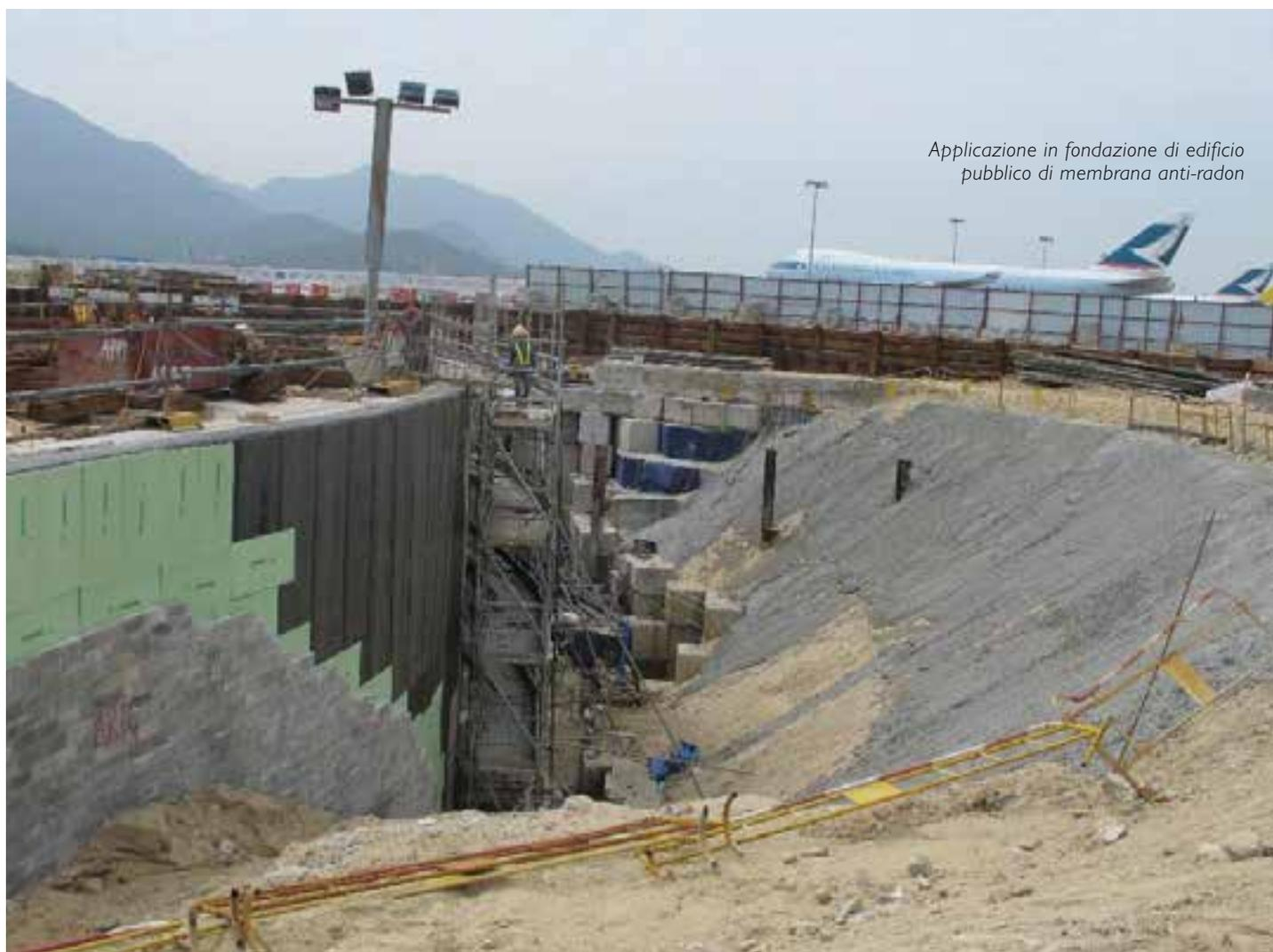
*Applicazione in fondazione di edificio pubblico di membrana anti-radon*
