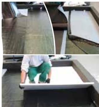
peratura necessaria per attivare completamente l'adesione del compound. La posa con colla bituminosa a freddo viene realizzata invece applicando uno strato omogeneo di questo materiale con delle racle apposite sul piano di posa; fintanto che la colla è fresca vengono srotolate e poste sopra di essa le membrane e successivamente sigillate le sormonte. Nella maggior parte dei casi questa sigillatura avviene a caldo con fiamma oppure con aria calda.
